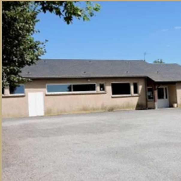
Vue de l'extérieur
